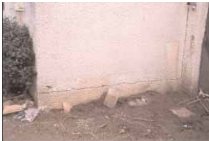
Fissuration horizontale
